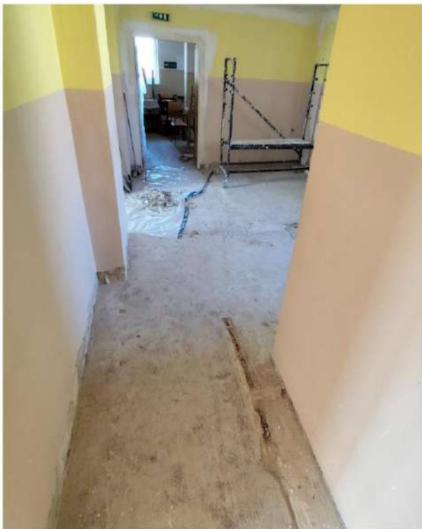
Pred rekonštrukciou- pavilón A
