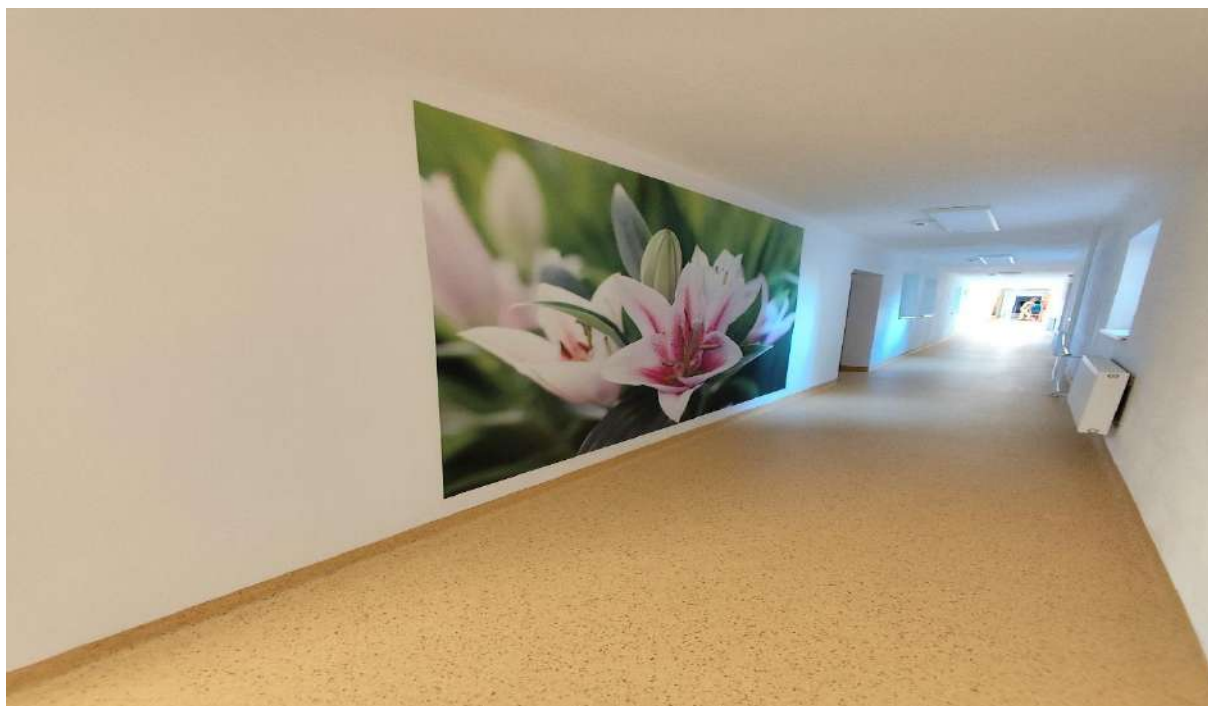
Po rekonštrukcii- spojovacia chodba
